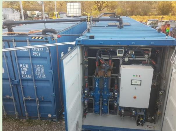
Die Containermodule kommen fixfertig an. Nur noch verrohren. Das Verfahren bedingt dünnflüssige Substrate.
