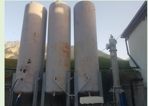
Die Batch Behälter für die Feststoffentfernung und rechts der Ammoniakstripper der die gesamte Abluft reinigt und daraus Dünger gewinnt.
